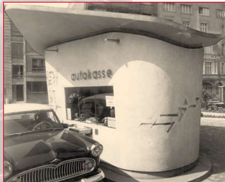
Autozweigstelle der Stadtparkasse in der Richard-Wagner-Straße
